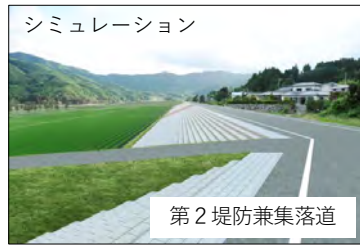
低地部のどこからでも避難できるように第2堤防を階段状にする。
